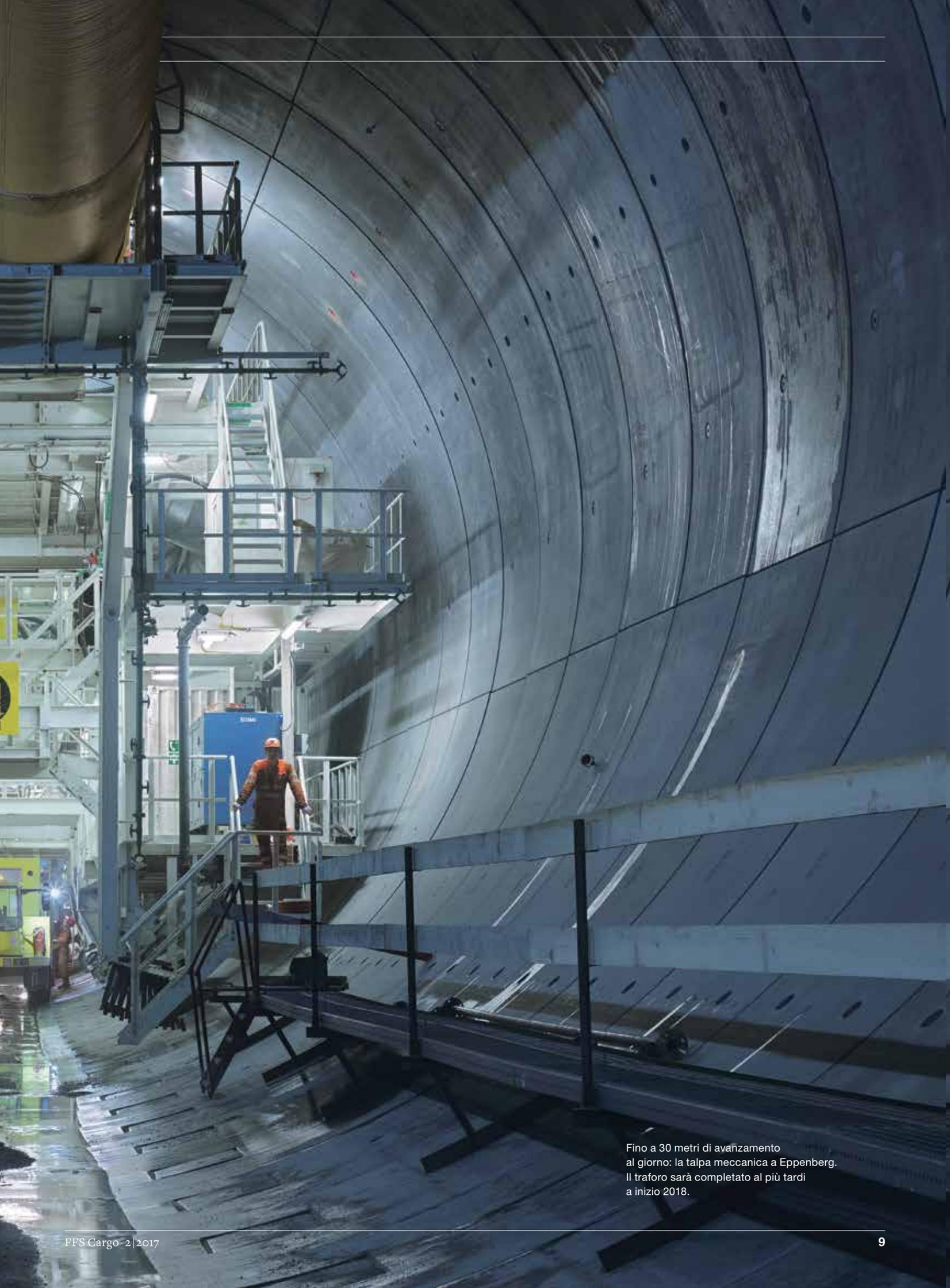
Fino a 30 metri di avanzamento al giorno: la talpa meccanica a Eppenbergh. Il traforo sarà completato al più tardi a inizio 2018.
