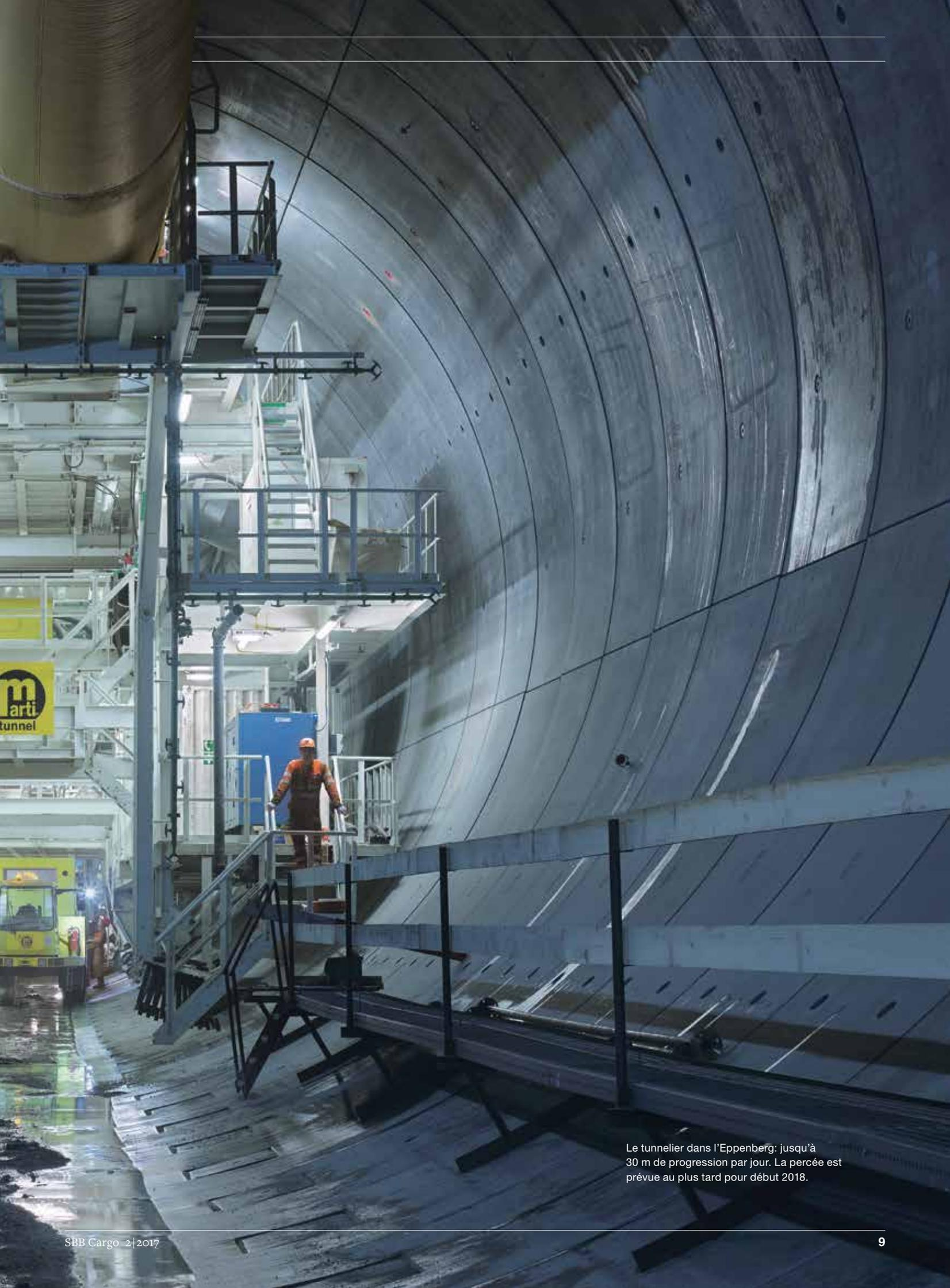
Le tunnelier dans l'Eppenbergl: jusqu'à 30 m de progression par jour. La percée est prévue au plus tard pour début 2018.
