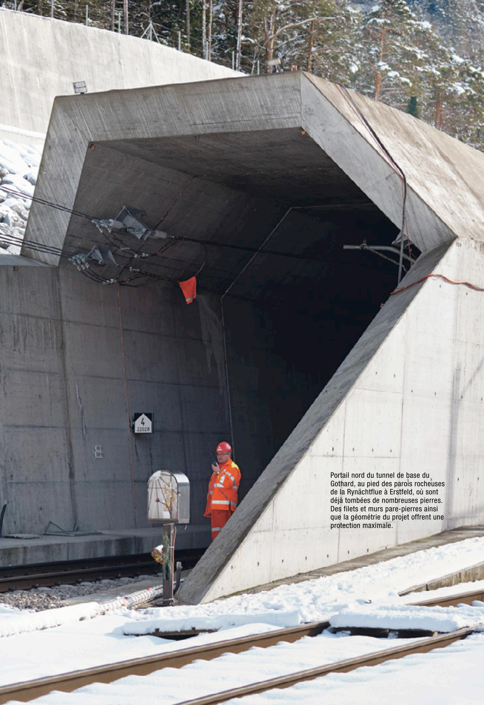
Portail nord du tunnel de base du Gotthard, au pied des parois rocheuses de la Rynächtflue à Erstfeld, où sont déjà tombées de nombreuses pierres. Des filets et murs pare-pierres ainsi que la géométrie du projet offrent une protection maximale.
