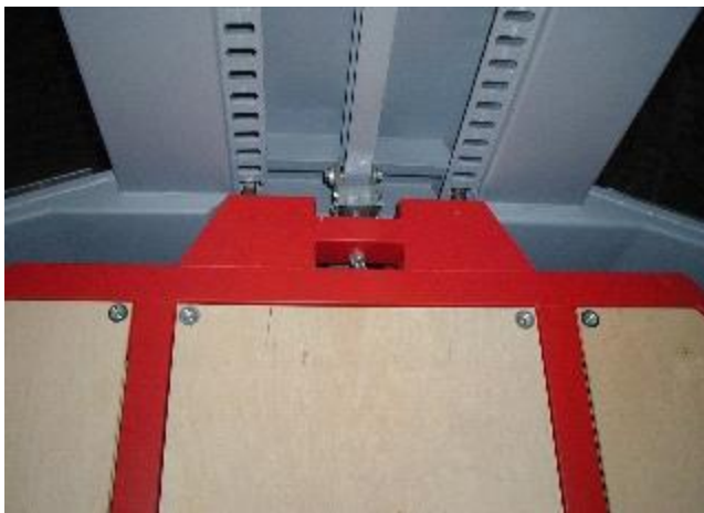
Aufhängung der Trennwand im Dach
