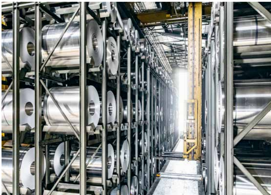
Il magazzino dei coil non è molto grande rispetto alla produzione giornaliera. Quindi occorre caricare le bobine sui carri ferroviari (foto a destra) e portarle via puntualmente.
