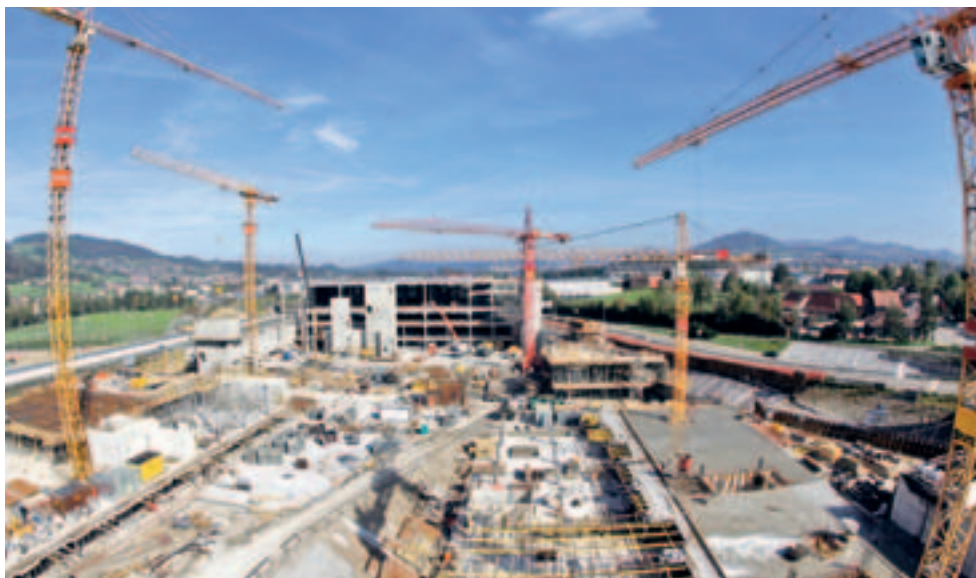
Meta finale per il cemento del Giura: il cantiere dello stadio di San Gallo.
