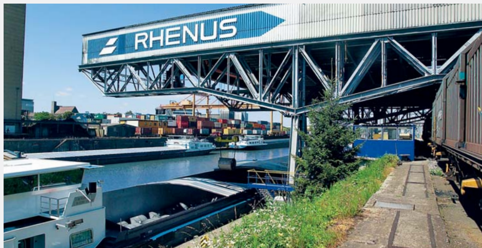
Terminal coperti per il trasferimento dei coil di acciaio dalla nave alla ferrovia.
