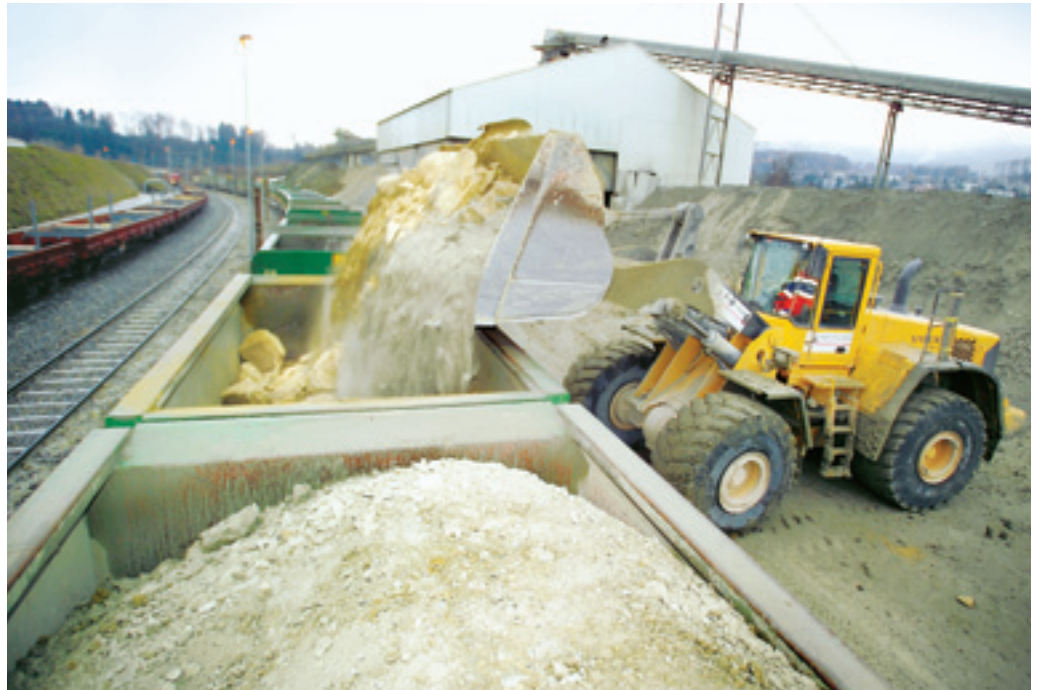
Il materiale di scavo proveniente dall'Uetliberg viene caricato per il trasporto.
