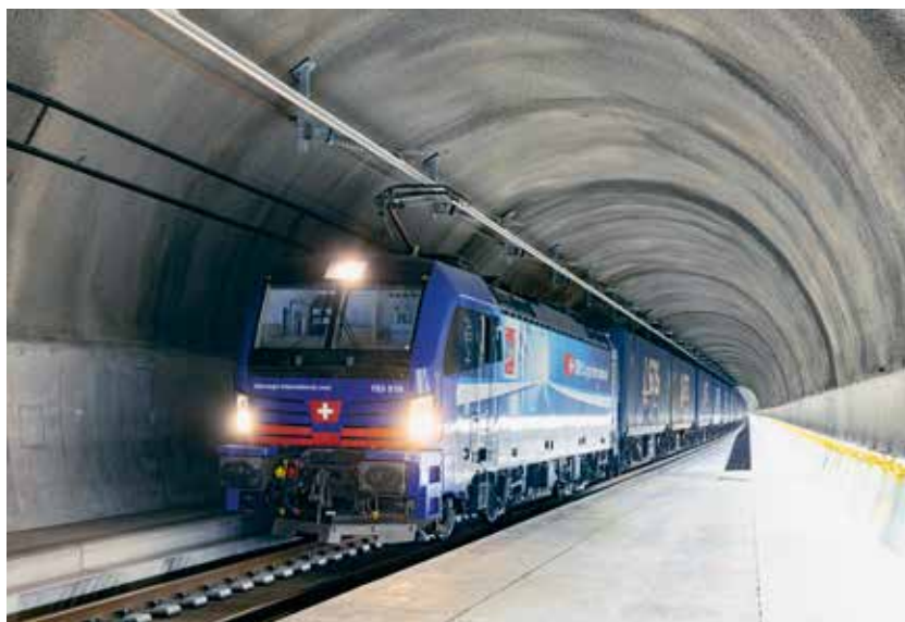
Le nouveau tunnel ferroviaire nous rapproche encore plus du sud du Tessin et de l'Italie.
