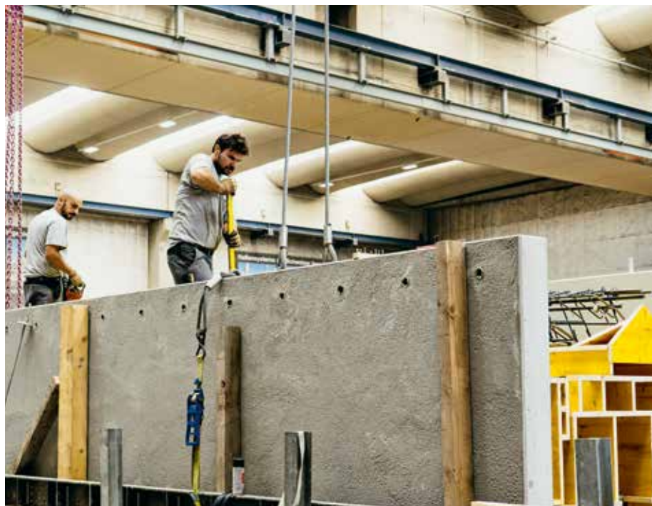
Lors d'un tour sur le site, les visiteurs ont pu découvrir les travaux menés par saw groupe.
