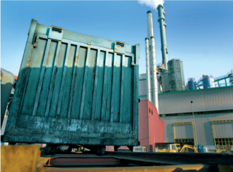
L'usine d'incinération de Weinfelden: pionnier dans le transport écologique des ordures.
