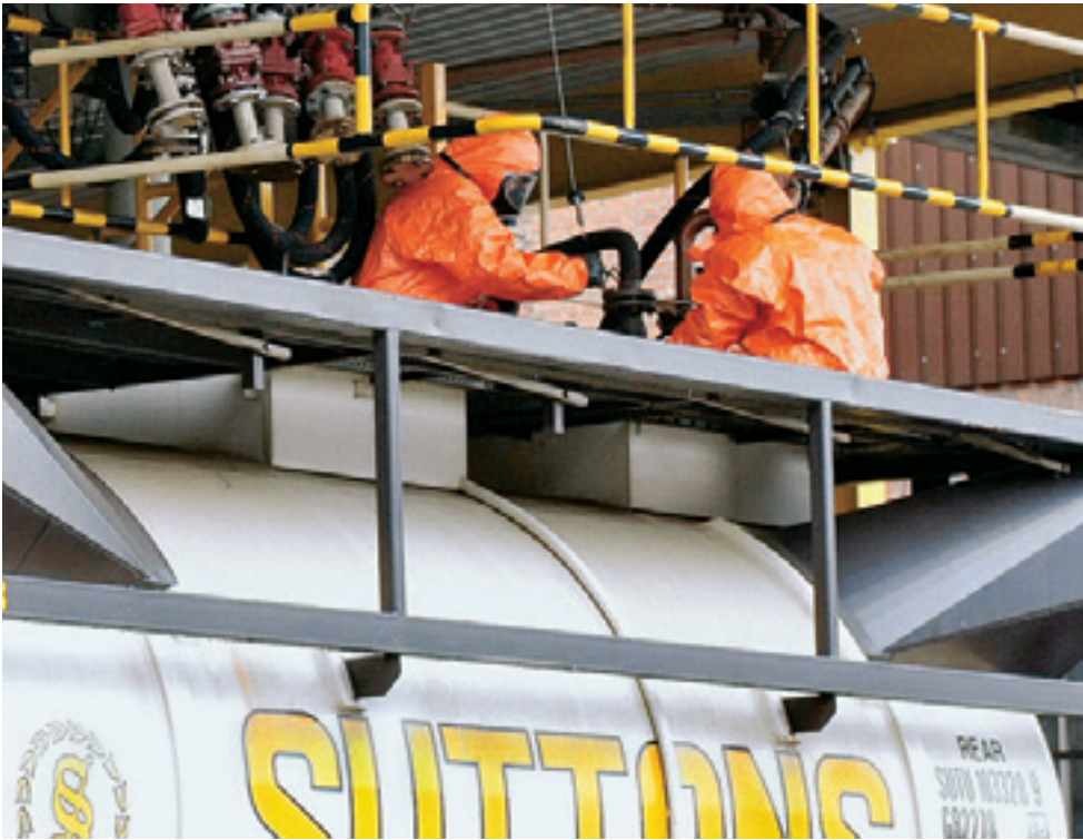
Chargement d'un wagon citerne avec du sulfate de diméthyle à Pratteln, près de Bâle.
