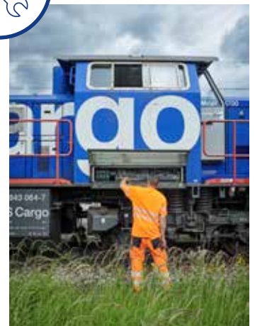
Wenige Handgriffe später ist das neue Rechnermodul eingesetzt.
