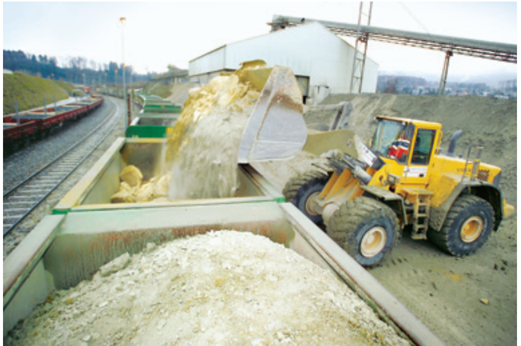
Das Ausbruchmaterial aus dem Innern des Uetlibergs wird zum Abtransport verladen.
